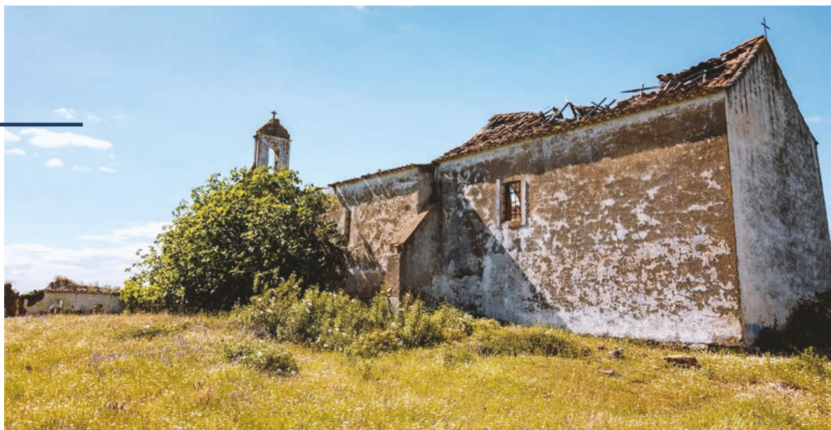
Zerfallenes Kirchengebäude im Dorf Safira | Montemor o Novo Município
