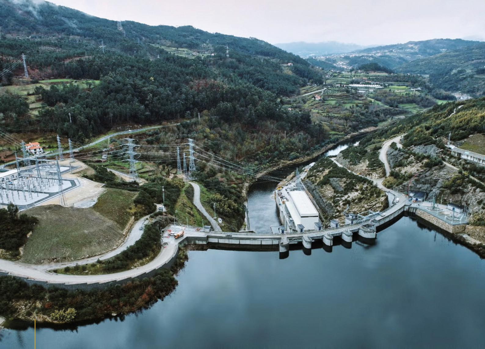
Foto: Staudamm des Rio Tâmega | www.power-technology.com
